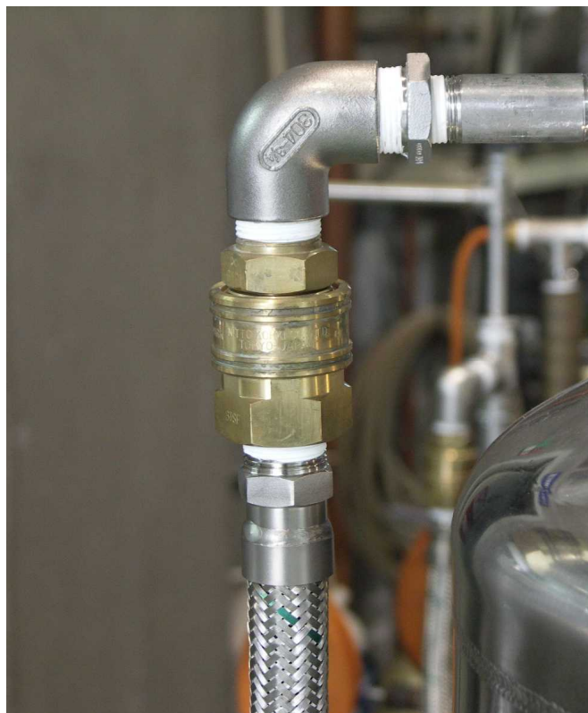
図 3. スイベル(回転継手)
