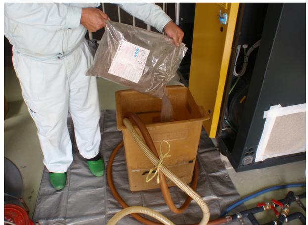
図 14. 薬品を投入して洗滌液の調製
