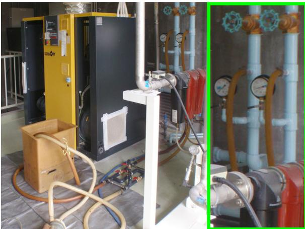
図 11. 圧縮機の洗滌回路
