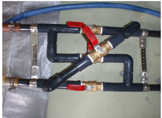
図 12. 洗滌液を流す向きの変更
