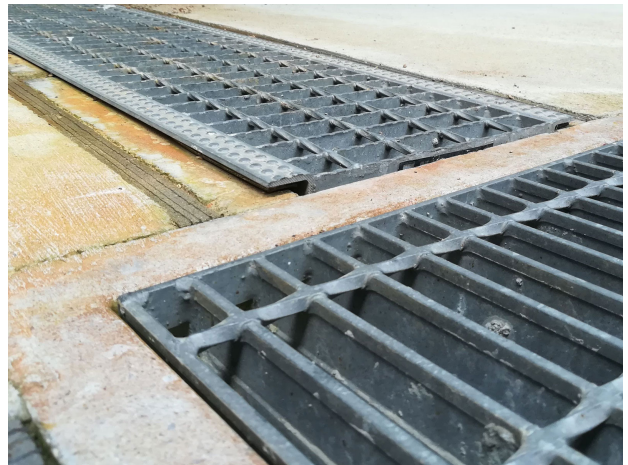
図 3. 支障した段差
