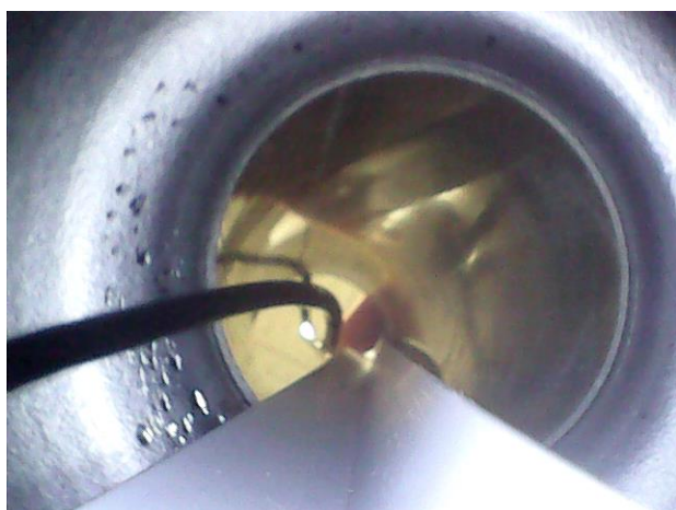
図 4. 内視鏡で内槽から見上げた首管
